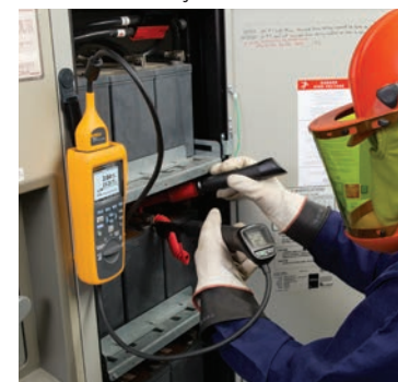
Mät impedans med Fluke BT521-batterianalysator.
